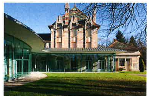
Extension de la gare de Nérès-les-Bains
