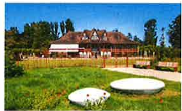
Pavillon du Golf à Bellerive sur Allier
