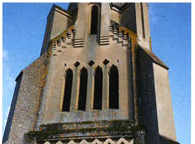
Ciment lissé sur le clocher de l'église de Couzon
