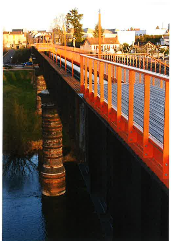
La passerelle du pont de fer à Moulins
