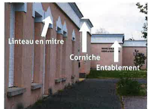
Groupe scolaire Pierre et Marie Curie à Montmarault et son « post-modernisme » puisant dans les références anciennes
