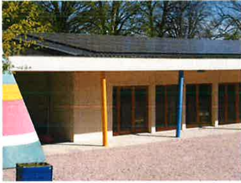
Pôle Enfance rive gauche à Bellèrive-sur-Allier, bénéficiant d'une norme HQE avec panneaux solaires et toiture végétalisée
