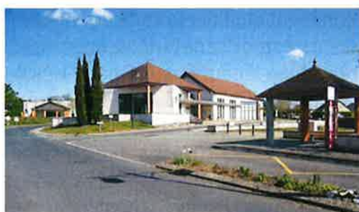
Ensemble mairie/salle des fêtes à Toulon-sur-Allier
