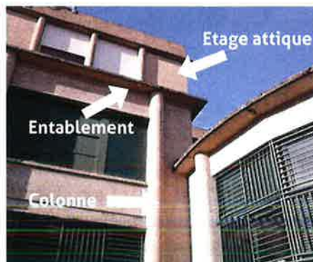
Détail de la Poste à Vichy
