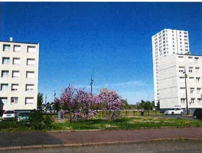
La percée créée par la «déconstruction» partielle de la barre des Ailes à Vichy
